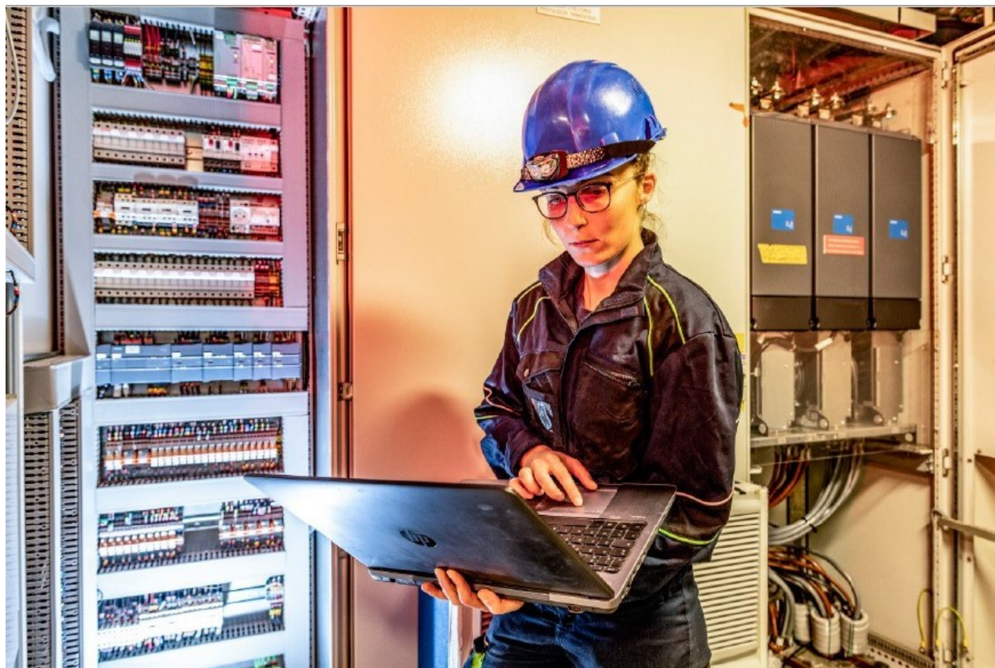
CLAIRE Ingénieure en électricité
